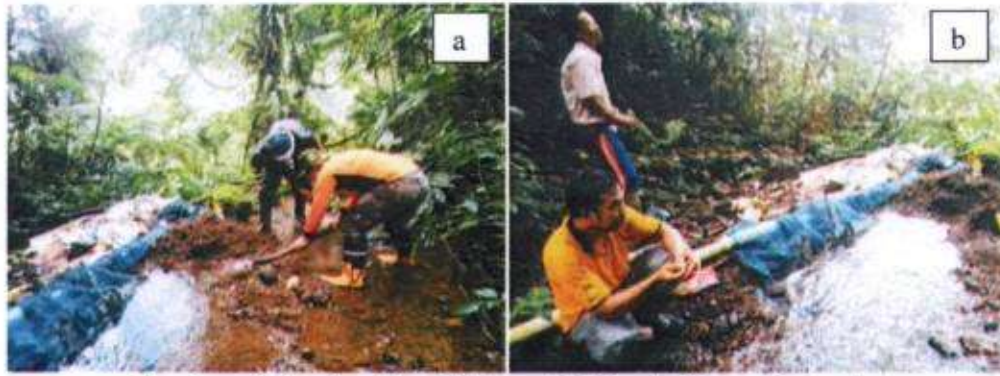
Gambar 9. Pembersihan Saluran Air Bersih Yang Tersumbat
