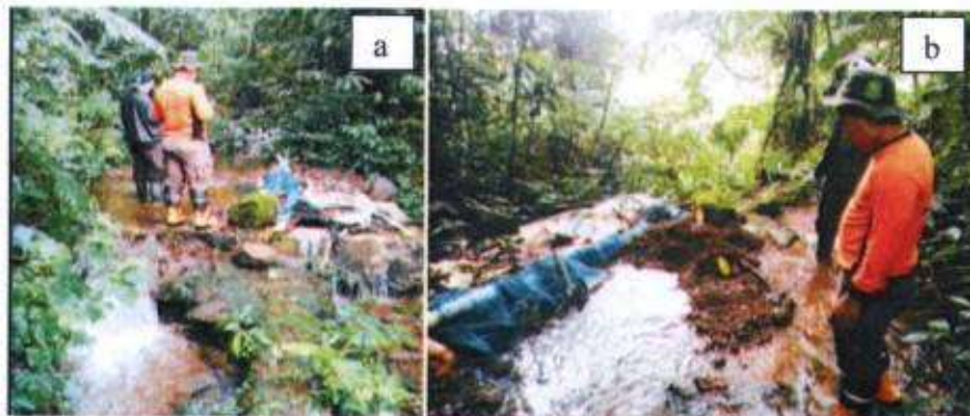
Gambar 7. Temuan Saluran Air Bersih Ke Areal Wisata Yang Tersumbat
