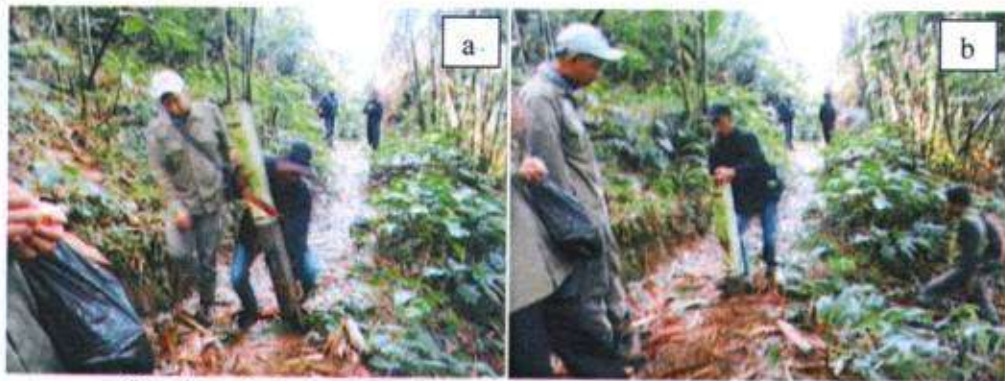
Gambar 8. Proses Pemasangan Kembali Patok Yang Tercabut
