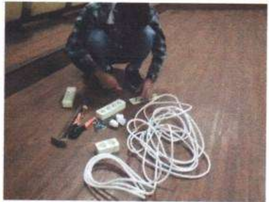
PEMASANGAN KABEL LISTRIK
