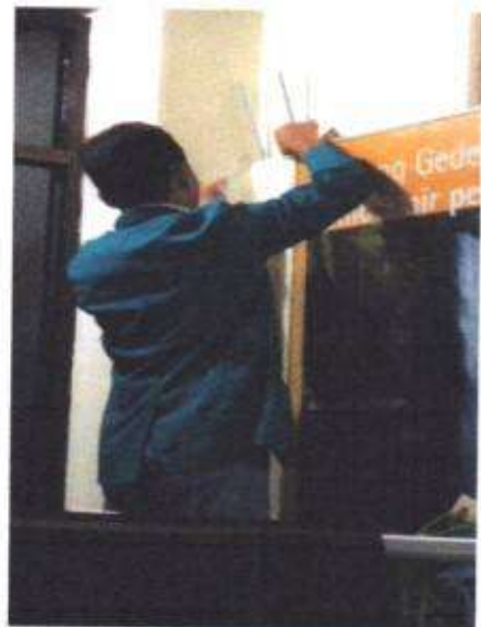
PEMASANGAN ACCESS POINT
